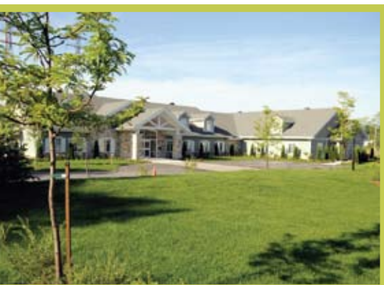
Extérieur de la Maison Adhémar-Dion
